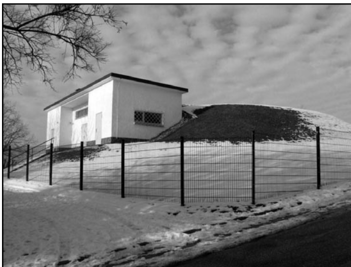
Der Wasserhochbehälter „Auf der Setz“
