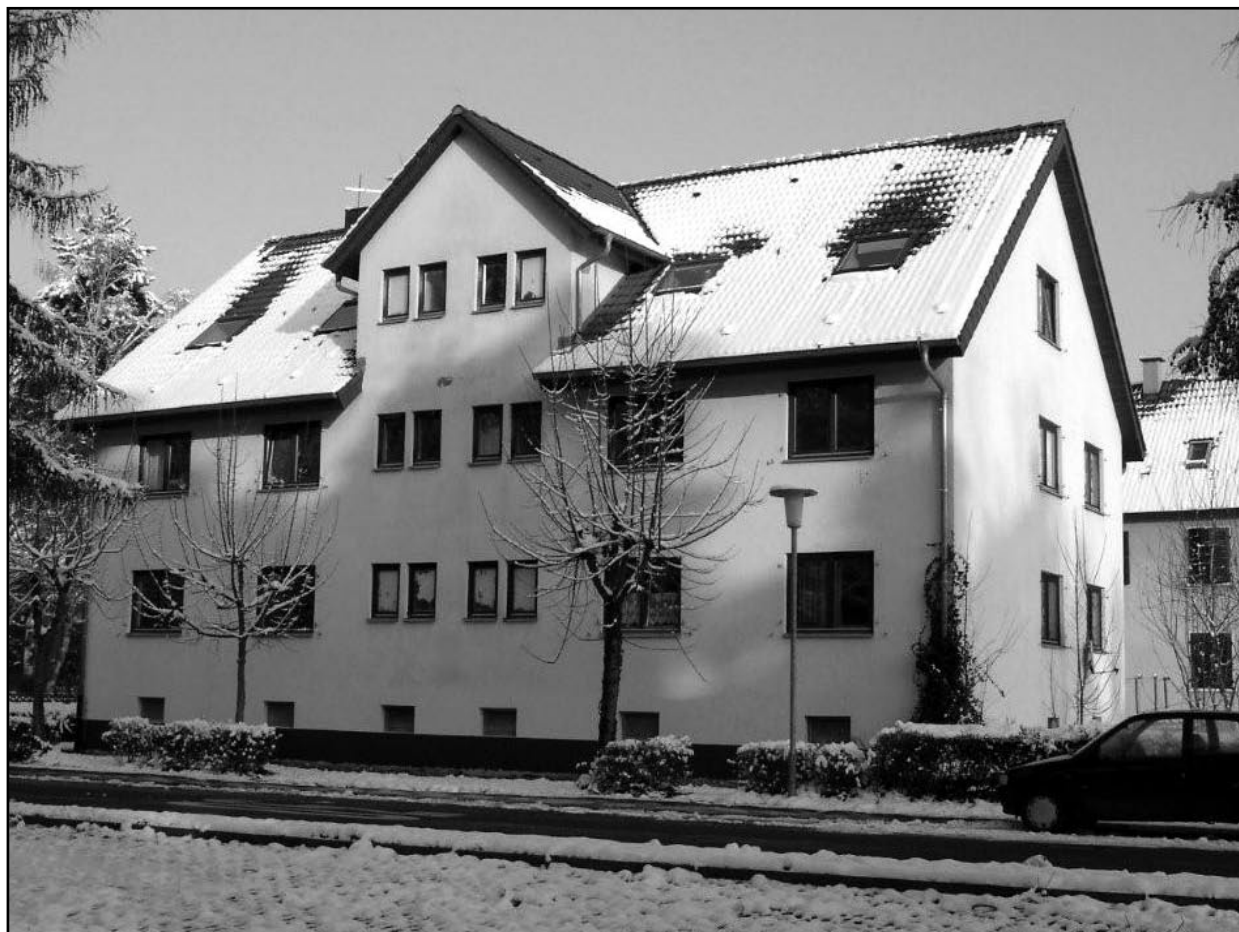
Künftiges Kinderhaus im Ortsteil Waldebrücke, ursprünglicher Zustand
