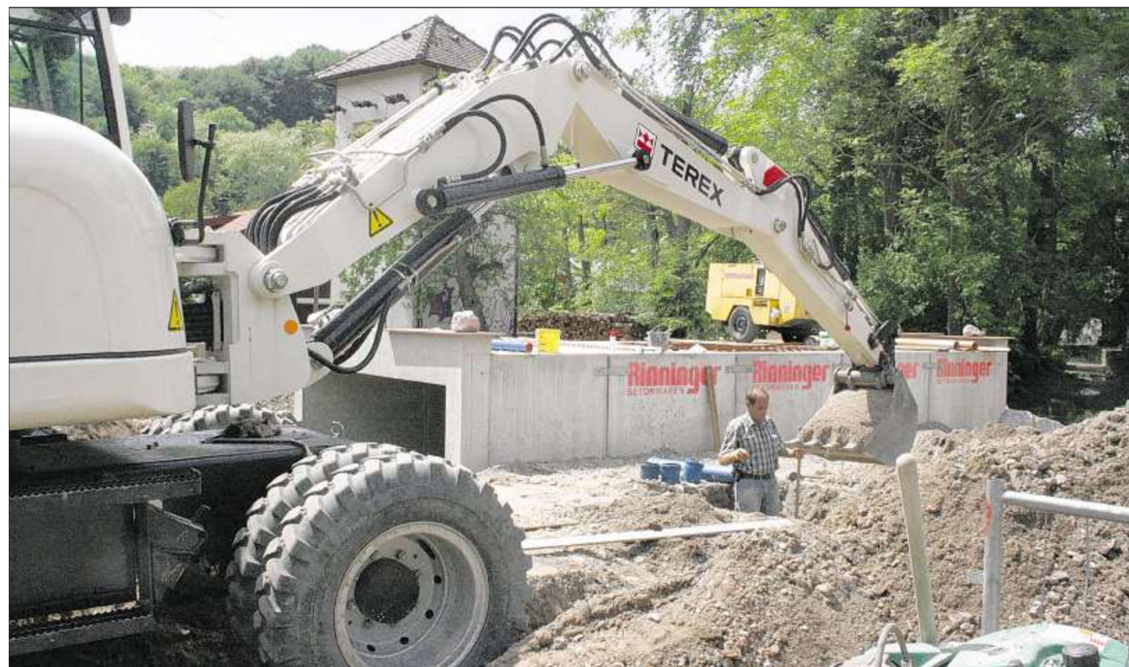
EIN AUFWENDIGES DURCHLASSBAUWERK ist im Walzbach erforderlich, um in der Heidengass den notwendigen Wendehammer anzulegen. Wenn die Bauarbeiten abgeschlossen sind, verschwindet das riesige Betonteil ganz in der Straße. Foto: Lothar
