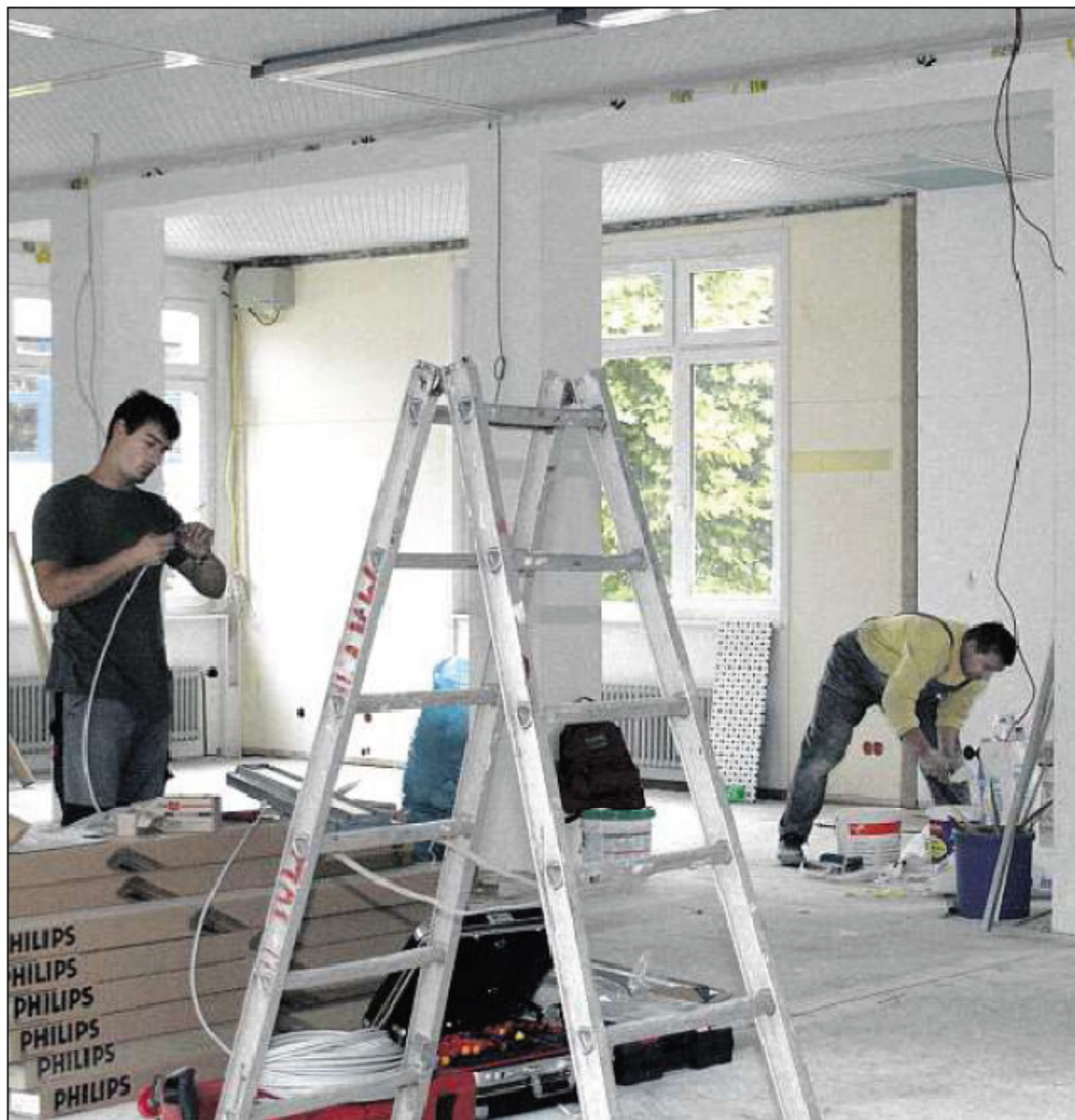
DER E-BAU der Turmbergschule wurde vollständig entkernt und eine neue Raumaufteilung vorgenommen.
