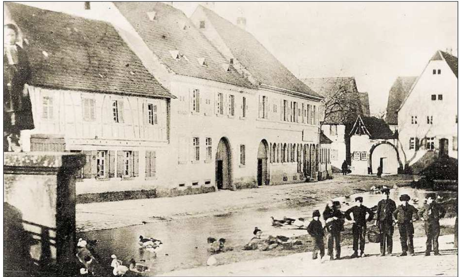
DER WALZBACH UM 1900: Das Bett war – auch nach der Erbauung der Tulla-Brücke – noch nicht fest mit Steinmauern gefasst. In noch früherer Zeit folgten die Postkutschen links dem Bachlauf, überquerten bei der Karistraße die Furt und bogen dort in Richtung Bruchsal ab. Foto: pr
