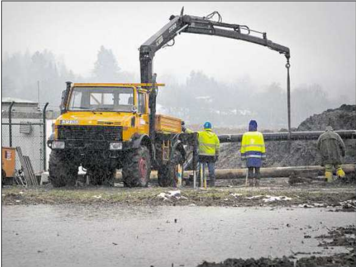
TROTZ DER ZUM TEIL sintflutartigen Regenfälle, die gestern auch das BNN-Hardtgebiet heimsuchten, gingen die Arbeiten an der Verlegung der Ehtylene Pipline in Weingarten weiter. Foto: wai
