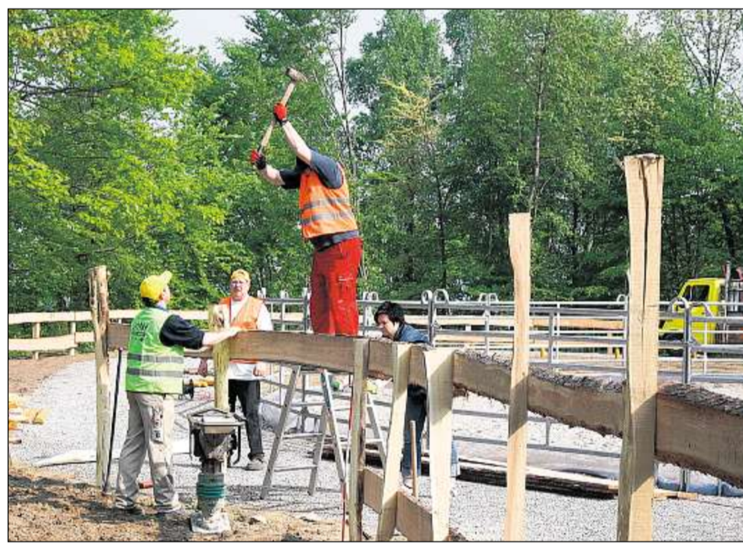
MÄCHTIG INS ZEUG mit „Durchschlagskraft“ legten sich Narren aus Württemberg, um beim Bau einer Therapie-Reitanlage für die Ludwig-Guttmann-Schule zu helfen. Foto: Müller
