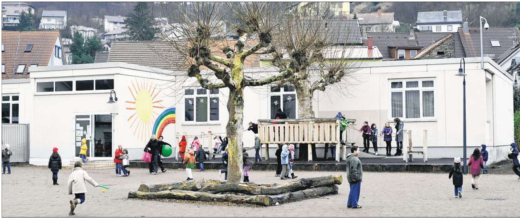
IM E-BAU DER TURMBERGSCHEULE in Weingarten soll ab dem kommenden Schuljahr die neue Mensa untergebracht werden. Für das Projekt rechnet die Gemeinde mit staatlichen Fördermitteln in Höhe von knapp 100 000 Euro. Das bestehende Gebäude wird zunächst komplett entkernt, danach werden die Räume neu eingeteilt und mit Küche, Mensa, Spiel- und Ruhezimmer wieder aufgebaut. Foto: Alàbisio
