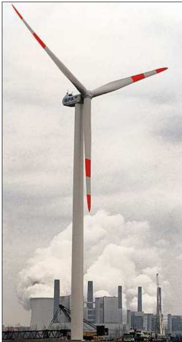
120 METER hoch ist dieses Windrad am Niederrhein. In Berghausen geht es um mehr. Foto: dpa
