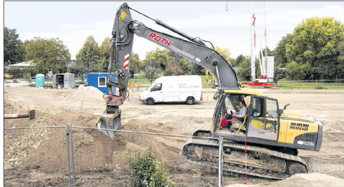
IM BLANKENLOCHER SEEGRABENWEG wird ein Wohnhaus errichtet, in das Flüchtlinge in der Anschlussunterbringung einziehen werden. In diesem Jahr verfügt die Stadt noch über genügend kommunalen Wohnraum. Foto: Alábliso
