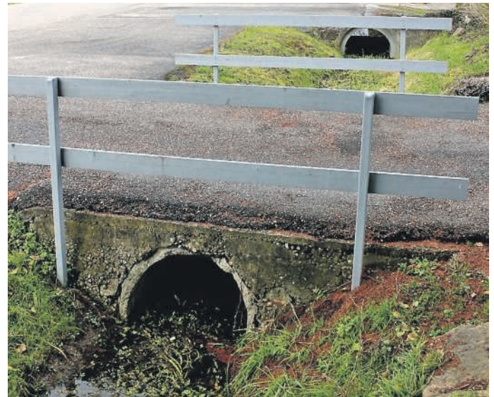
Bei der Regenwasserkonzeption spielt zum Beispiel der Breitwiesengraben für den nördlichen Ortsteil als Vorfluter eine wichtige Rolle Fotos: prf
