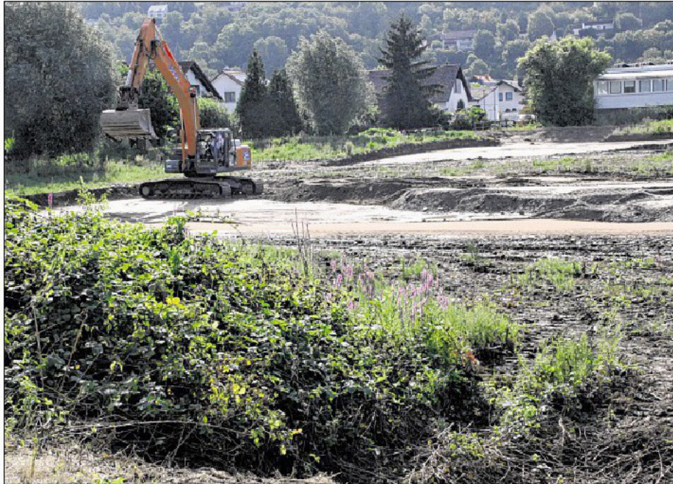
DIE VORBEREITENDEN ERDARBEITEN laufen derzeit im Baugebiet „Moorblick“ an der Rückseite der Walzbachhalle. Foto: Lother
