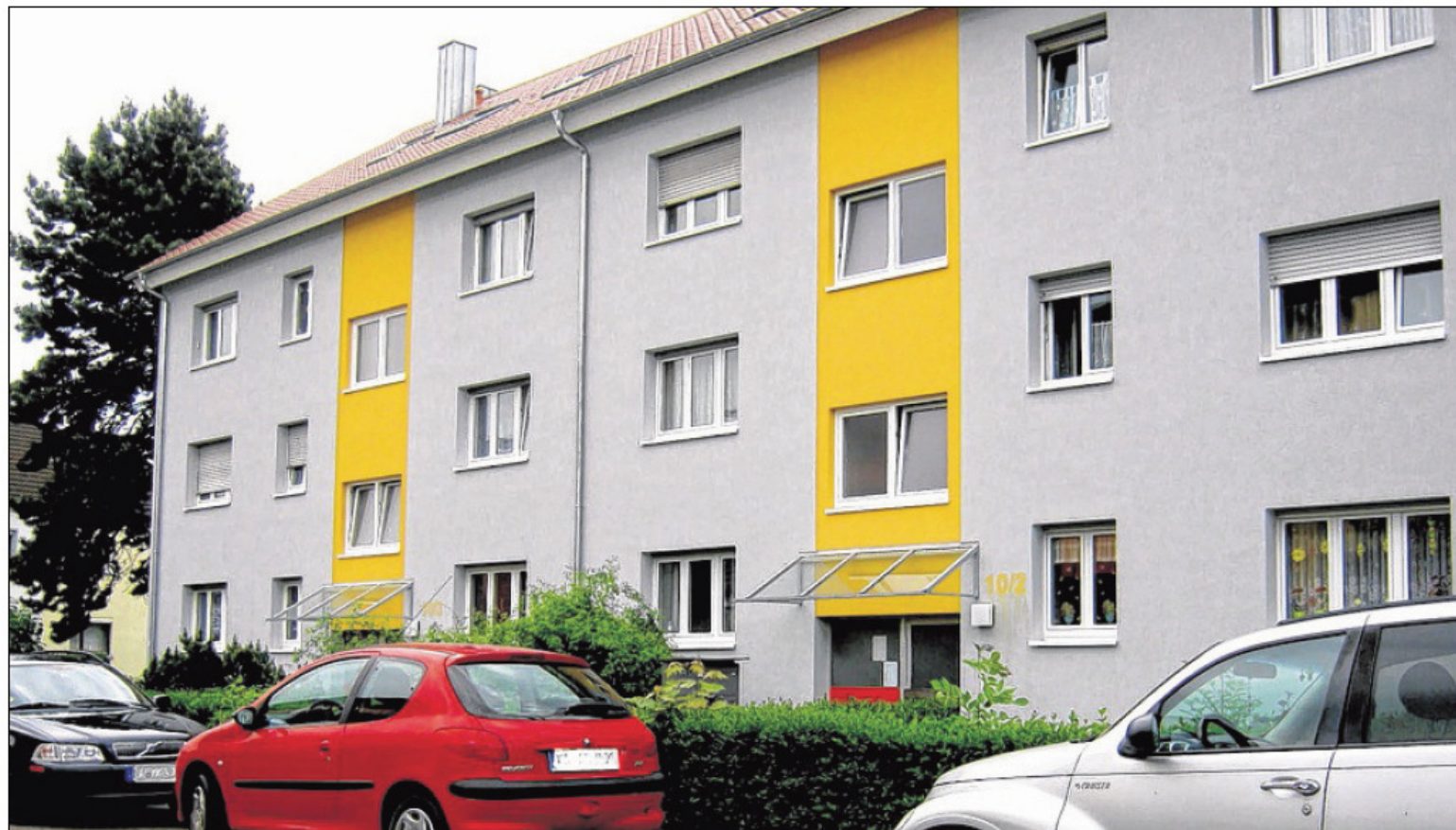
DIE BEIDEN WOHNHÄUSER in der Goethestraße 10/2 und 10/3 der Baugenossenschaft wurden im vergangenen Jahr energetisch saniert und erstrahlen jetzt in einem neuen Glanz.
