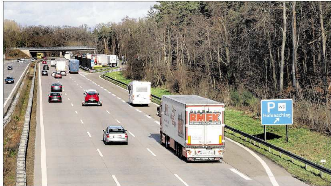
DIE ZUFAHRT ZUR BAUSTELLE wird nun doch nicht beim Parkplatz Höfenschlag notwendig, da sie von der Autobahn 5 über die Behelfsausfahrt an der Landesstraße 559 erfolgen kann. Foto: Lothar
