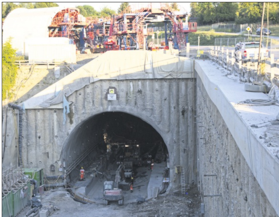
MIT DEM EINBAU DER TUNNELINNENSCHALE wurde nun in Pforzheim begonnen. Ungefähr acht Monate werden die Betonarbeiten dauern. Foto: Helbig
