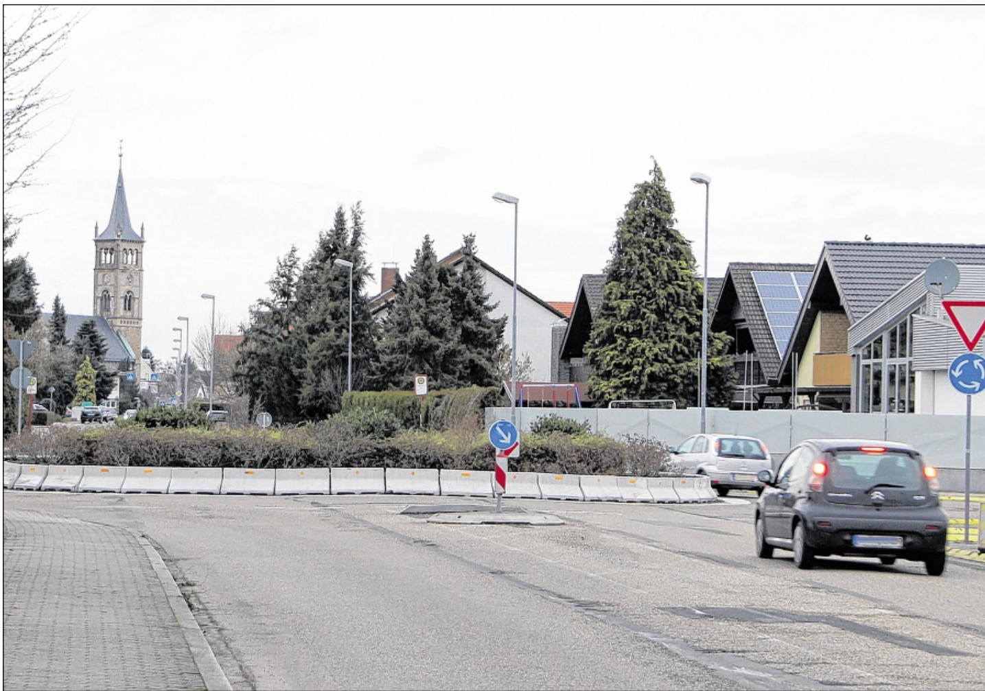
ZU DEN INVESTITIONEN des Landkreises in diesem Jahr zählt auch der Kreisverkehr am Ortseingang in Neuthard im Zuge der Kreisstraße 3529, der mit einem Aufwand von etwa 400 000 Euro neu gestaltet werden soll. Foto: Herberger
