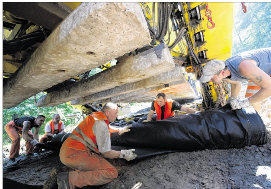
UNTER DAS ANGEHOBE NE GLEIS kommt noch vor dem Schotter ein Vlies zur Abdichtung und darauf noch Sand.
