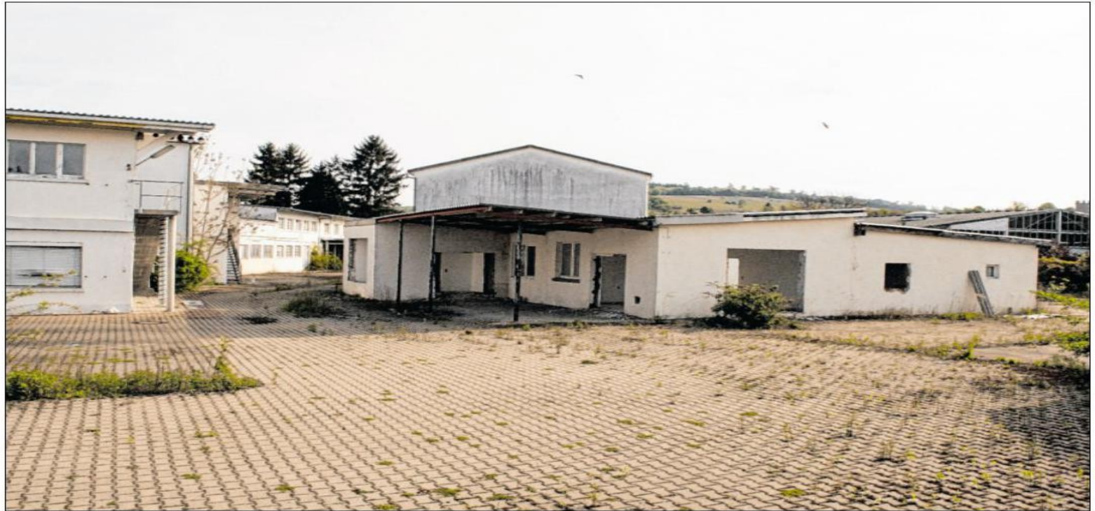
AUF DEM GELÄNDE der ehemaligen Lackfabrik Schwaab soll das Projekt „mittendrin leben“ entstehen. Wann das Vorhaben realisiert wird ist ungewiss, nachdem der Grundstückseigentümer seinen Rücktritt vom Kaufvertrag an einen Investor erklärt hat. Foto: Lothar
