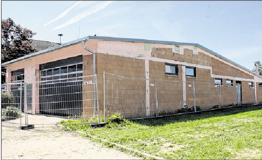
DER ANBAU an das Feuerwehrhaus befindet sich auf der Seite zur Mineralix-Arena und ist im Rohbau so gut wie fertiggestellt. Foto: Lothar
