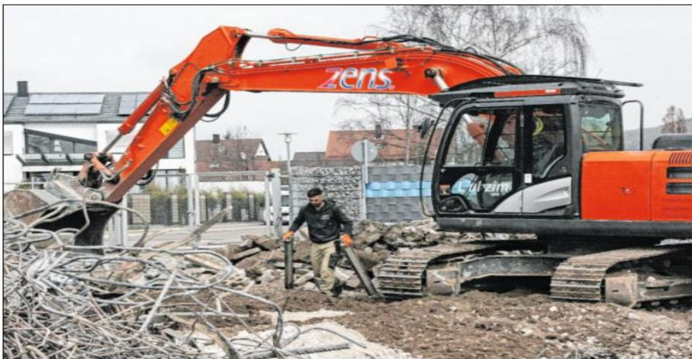
EINE ABBRUCHFIRMA reißt das alte Gebäude der Telekom auf dem rückwärtigen Bauhofgelände ab. Foto: Lothar
