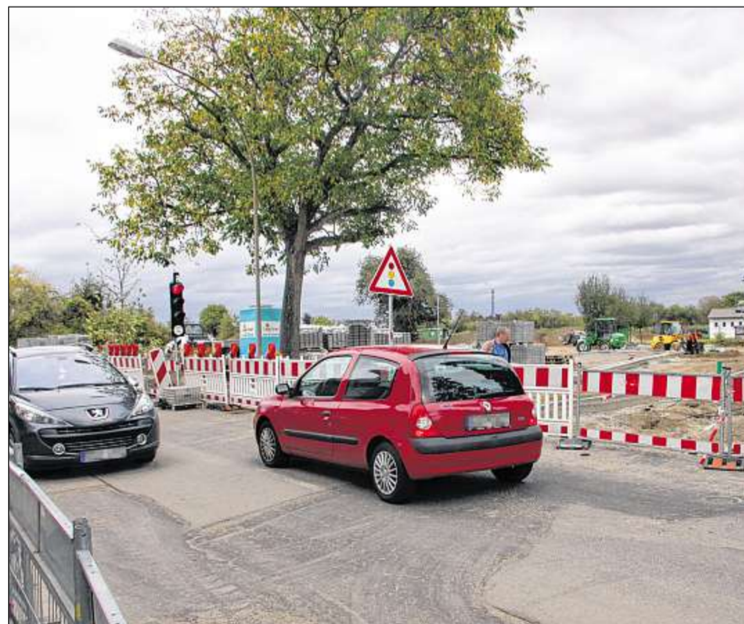
VON DER ADLERSTRASSE aus wird das neue Baugebiet am Spöcker Ortsrand erschlossen. Die Straße ins Wohngebiet wird nach Ferdinand Hofheinz benannt. Die Erschließung soll bald fertig sein. Foto: del
