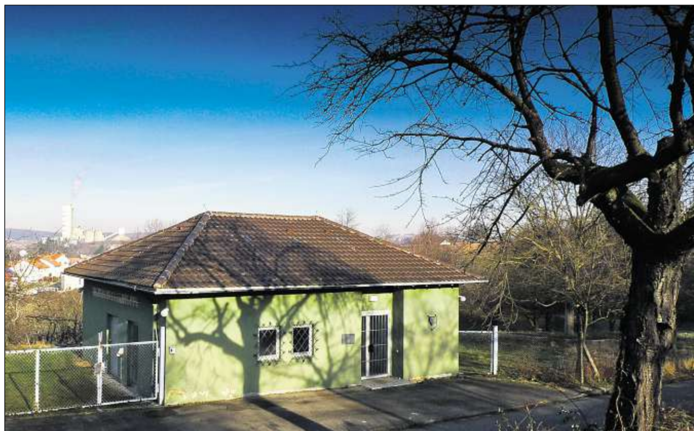
DIE WASSERENTHÄRTUNGSANLAGE im Hochbehälter am Herdweg ist für Wolfgang Eberle ein Stein des Anstoßes. Er bemängelt bei der Etatverabschiedung in Walzbachtal, dass es dazu keine Information aus dem Rathaus gebe. Foto: Waidelich
