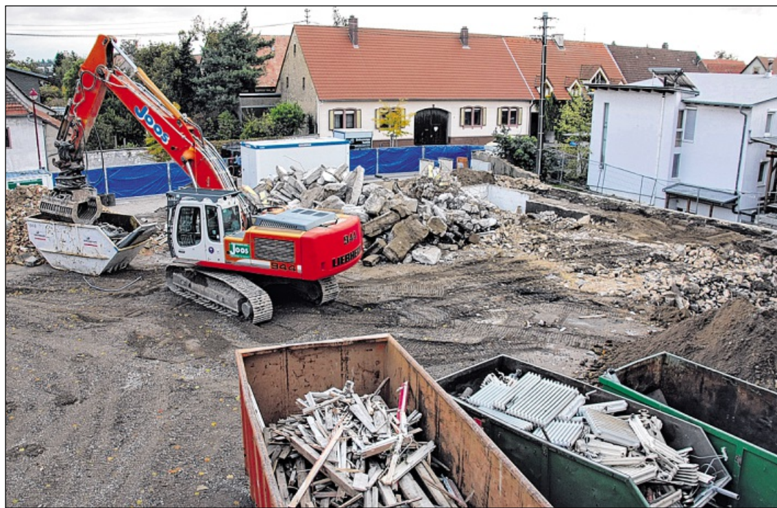
ALTBESTAND BESEITIGT: Die Abbruchteile sind sauber nach Beton, Metall und Holz getrennt und liegen zum Abtransport bereit. Für die „Arche Noah“ investiert Graben-Neudorf vier Millionen Euro. Foto: Gamer
