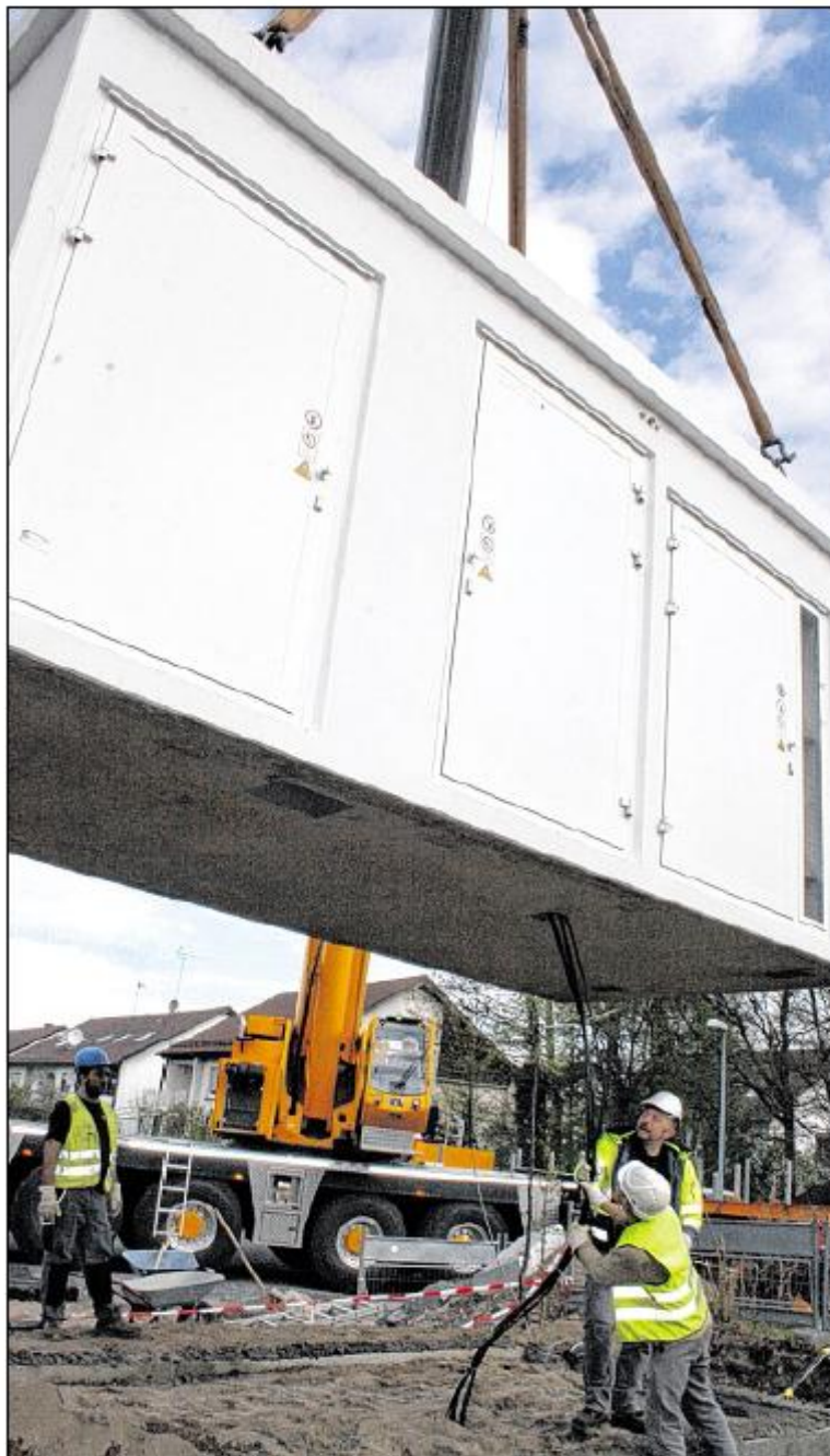
MIT EINEM SCHWEREN KRAN wurde jetzt die erste Erdgastankstelle in Weingarten aufgestellt. Foto Lothar
