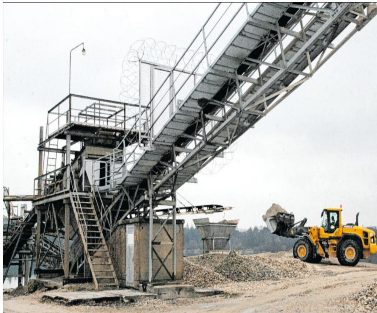
EINEINVIERTTEL MILLIONEN KUBIKMETER – rund zwei Millionen Tonnen – Kies und Sand sollen mit der Erweiterung am Baggersee in Weingarten gewonnen werden. Die letzte Ausdehnung des Abbaubereichs umfasst rund sechs Hektar Fläche. Foto: Lother
