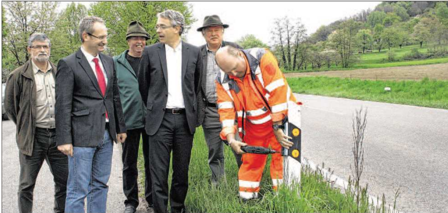
EINEN SPEZIELLEN REFLEKTOR bringt ein Straßenbauamtsmitarbeiter an einem Leitpfosten an. Hilfe gegen Wildunfälle erhoffen sich davon (von links) Thomas Eichkorn, Eric Bänziger, Werner Mumbauer, Christoph Schnaudigel und Thomas Hauck. Foto: Lothar
