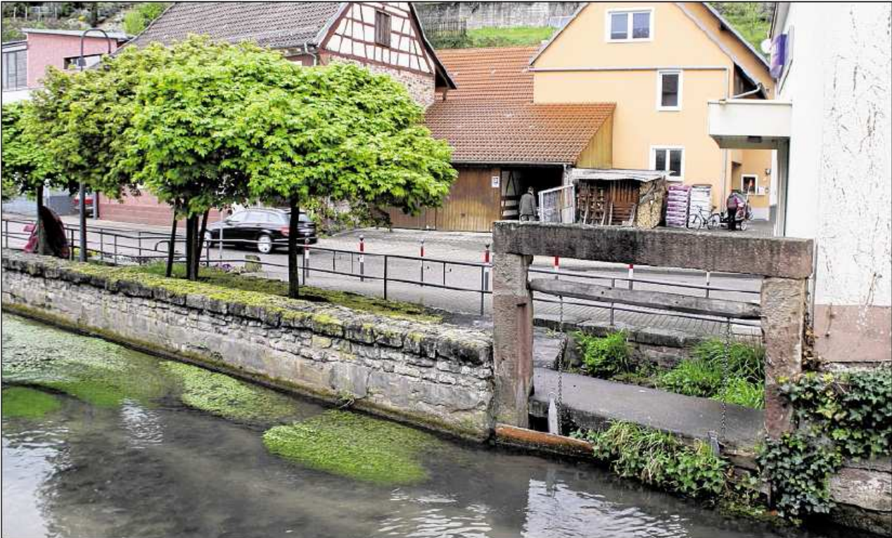
SEIT VIELEN JAHREN UNBENUTZT ist die Stellfalle am Walzbach auf der Höhe des Blumengeschäfts in der Jöhlinger Straße. Sie trennt den Walzbach von einem künstlich angelegten Seitenkanal. Foto: Lothar
