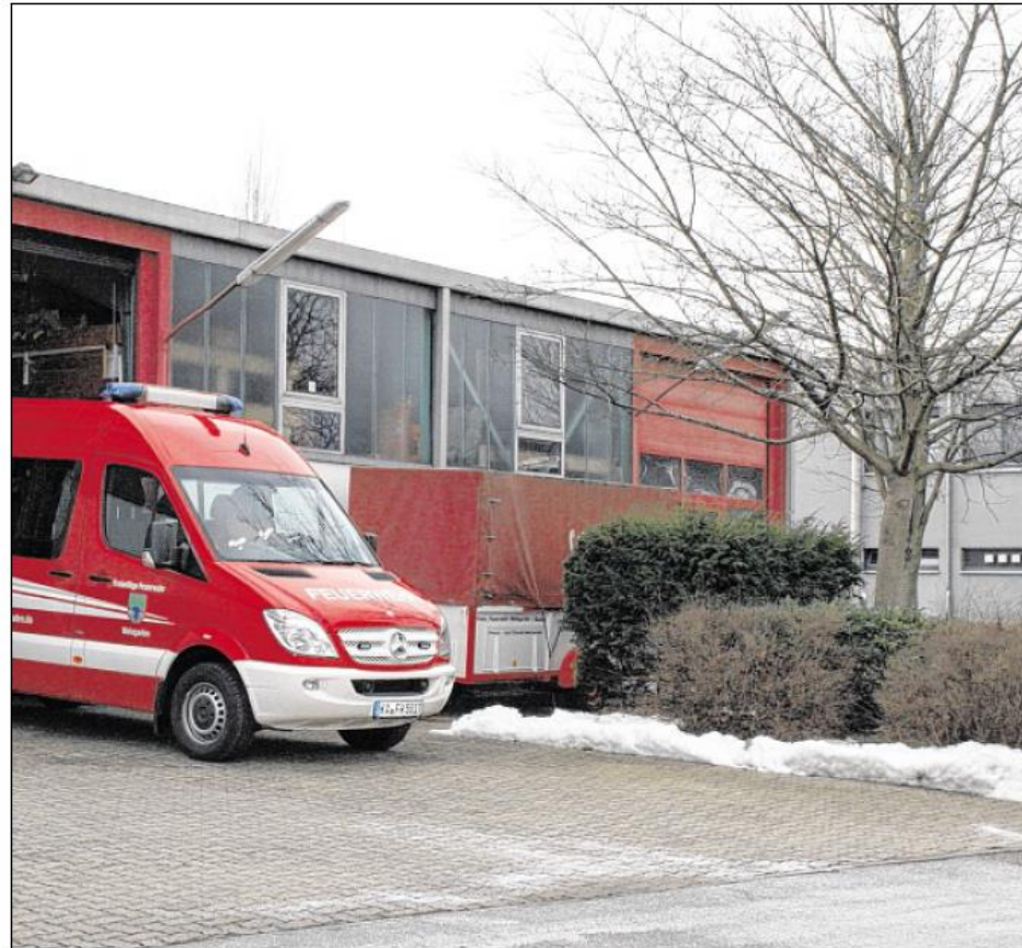
DER NEUE ANBAU schließt sich an das rechte Ende des Flachbaus an und wird auf der Wiese zwischen Gerätehaus und Kleiberit-Arena errichtet. Foto: Lothar
