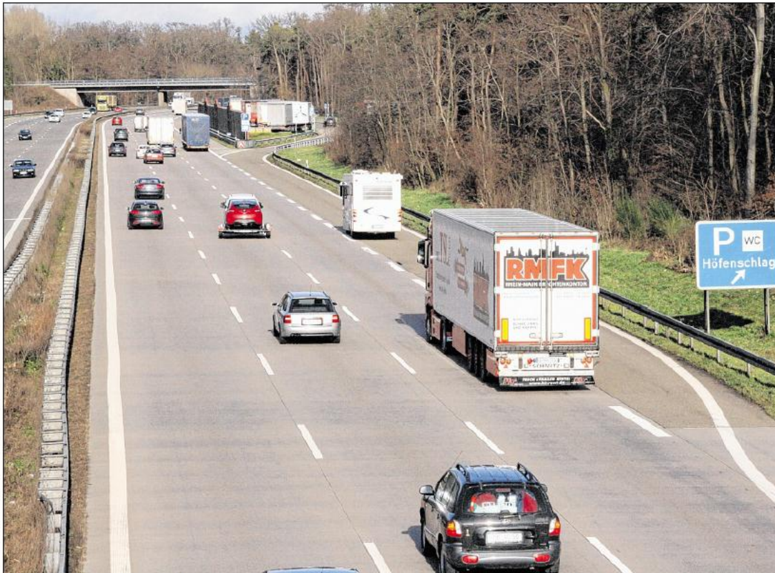
OFFENBAR EIN STÜCKCHEN NÄHER GERÜCKT ist der Bau des Lärmschutzwalls zwischen dem Weingartener Ortsteil Waldbrücke und der Autobahn 5. Die ersten Rodungen für das Projekt könnten im Winter beginnen. Foto: Lothar
