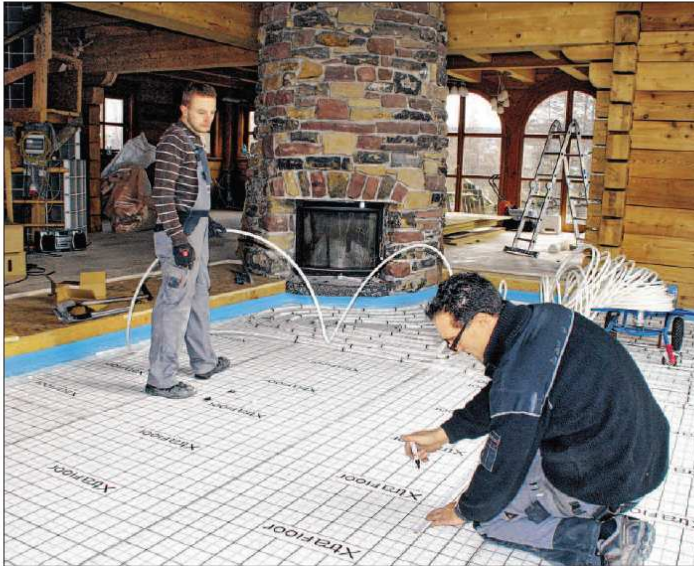
EINE FUSSBODENHEIZUNG wird sowohl im zweigeteilten Gruppenraum wie im Mehrzweckraum des ehemaligen Wohn- und Geschäftshauses installiert. Im April zieht dort eine Ganztagsgruppe mit 20 Kindern ein. Foto: Lothar
