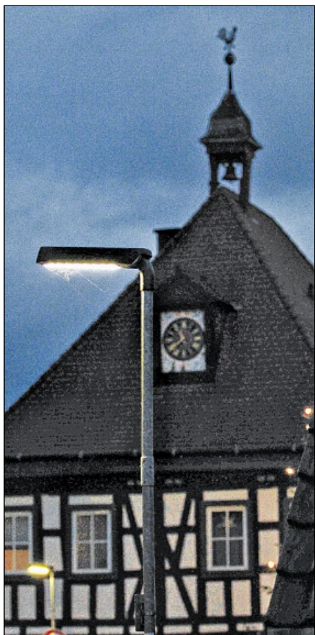
NEUES LICHT am alten Rathaus in Wössingen: LED-Straßenlampe in Betrieb.
