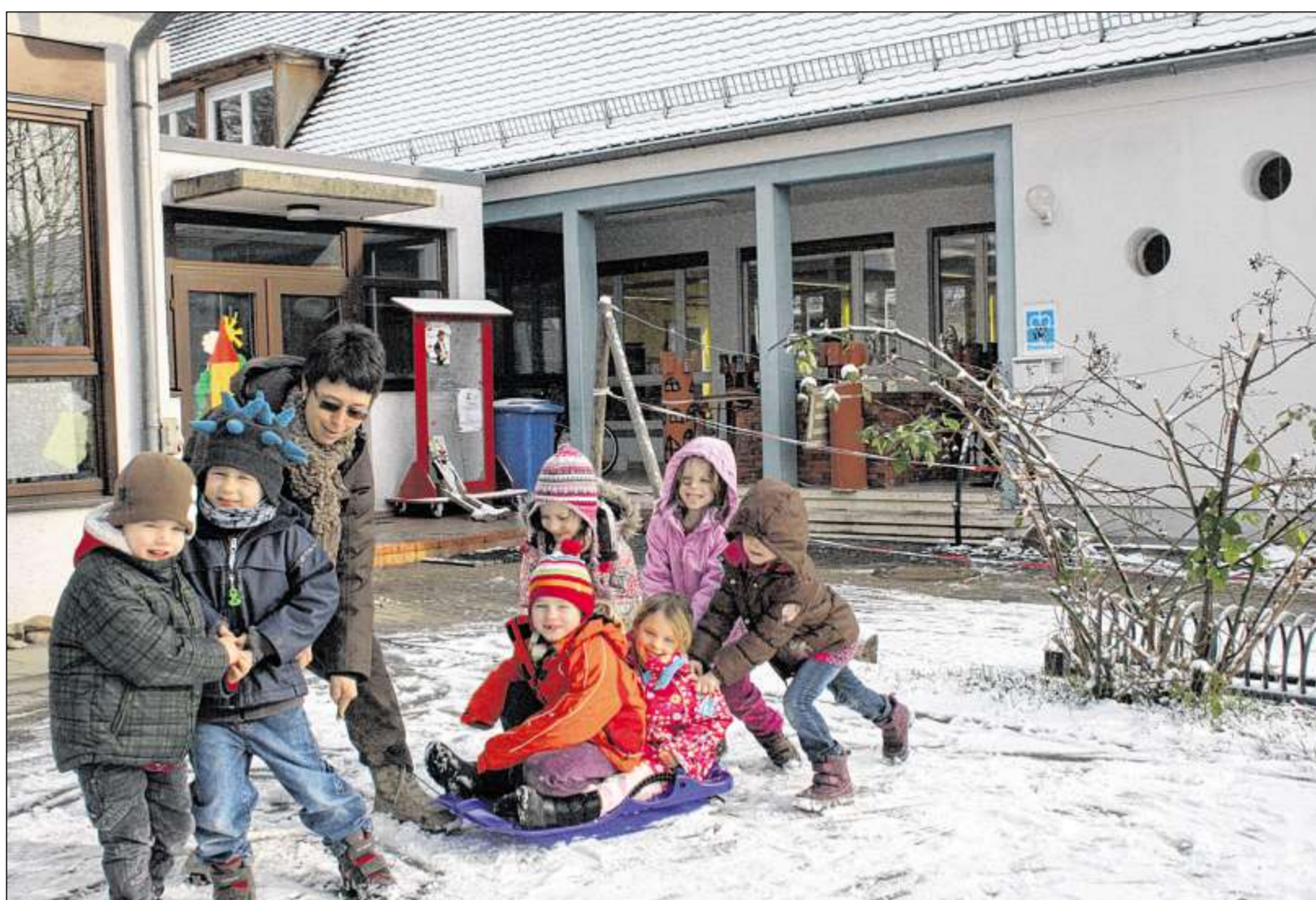
GRÖSSTER POSTEN UNTER DEN PROJEKTEN 2012 im Weingartener Gemeindehaushalt ist mit insgesamt 1,25 Millionen Euro der Kindergarten in der Waldbrücke. Der rechte alte Gebäudeteil (auch im Bild rechts) wird durch einen Neubau ersetzt. Foto: Lother
